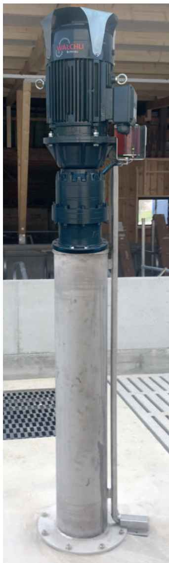
Erhöhte Montage auf Konsole im Laufstall
