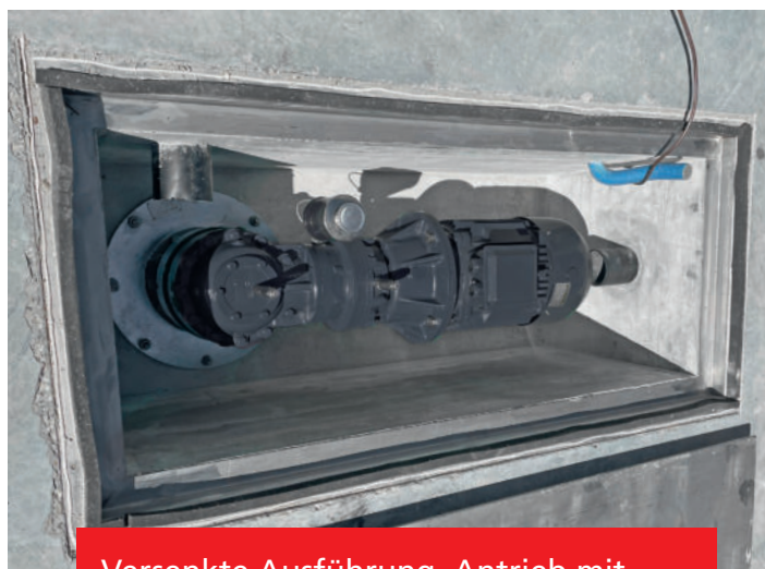
Versenkte Ausführung, Antrieb mit Winkelgetriebe und Motor
