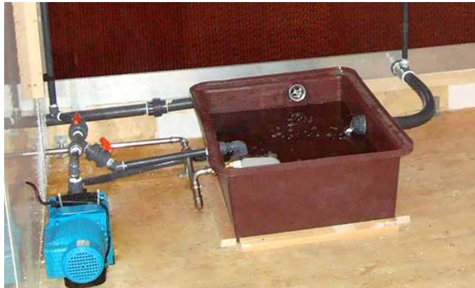
Der Vorbehälter ist mit einem Wasserzufluss samt Schwimmer ausgestattet. Damit kann das verdunstete Wasser wieder aufgefüllt werden.
