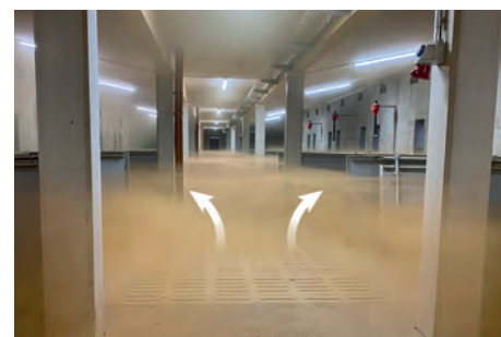
Gekühlte Frischluft strömt ohne Zugluft in den Liegebereich
